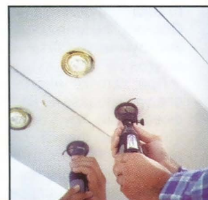
Вырезание монтажных отверстий по разметке
