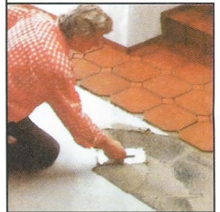
Укладку плиток ведут участками. Сначала на основу наносят клей.
