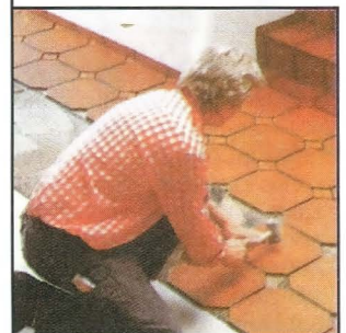
На клей, слегка надавливая, кладут восьмиугольные плитки. Укладку ведут как обычно, то есть параллельными рядами.
